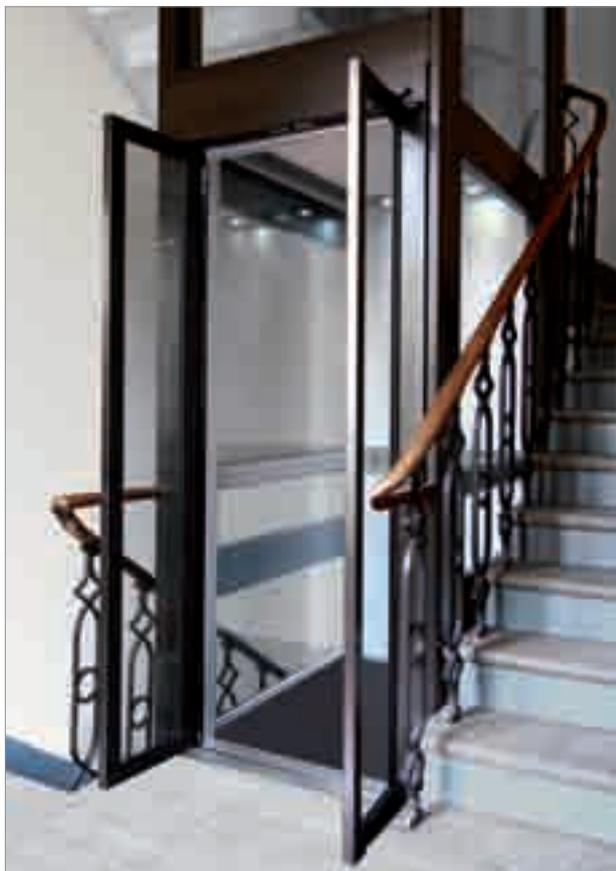
Porta di piano a due battenti ed a soffietto in cabina con apertura e chiusura completamente automatica. Dotata di dispositivo di sicurezza che interrompe il movimento in caso di ostacolo.
